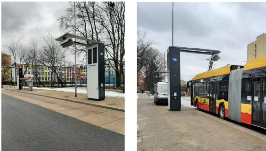
Figura 5. Reportaje fotográfico de pantógrafo estándar (all-i-one)
