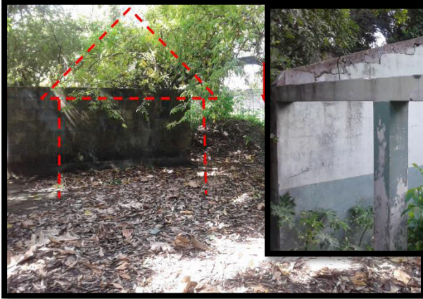
Foto 1 : Estado Inicial solar
